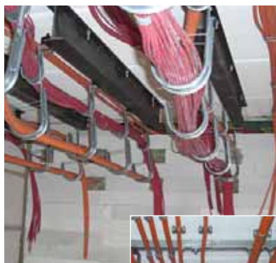
Установка внутри огневой камеры
